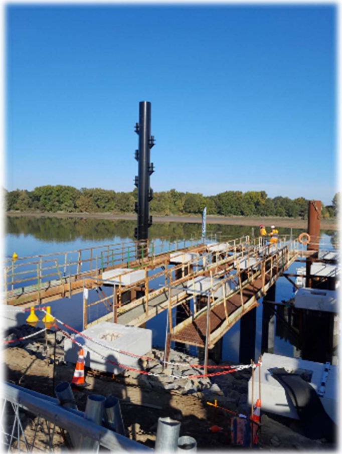
Création de l'estacade : Passerelles temporaire et mise en place des ducs d'albe (sept. Oct.2023)
