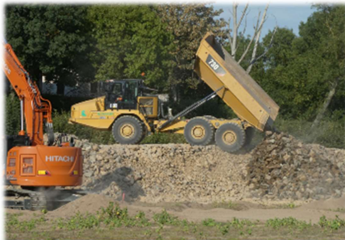
Mise en stock des enrochements devant être réemployés pour l'aménagement du secteur C
