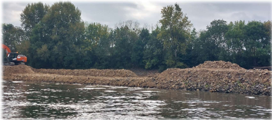
Réouverture du bras des Babins (île Briand) par remodelage de la chevette (abaissement et échancrure)
