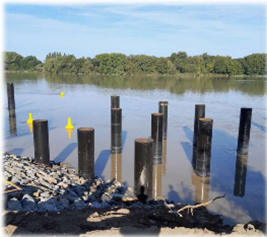
Création de l'estacade : Passerelles temporaire et mise en place des ducs d'albe (sept. Oct.2023)
