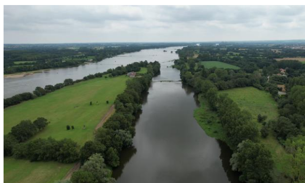
Photo 2 Vue de la connexion amont
