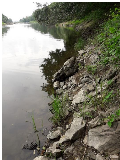
Photo 10. Vue des habitats en rive gauche (enrochements, berges abruptes) Vue de l'aval vers l'amont
